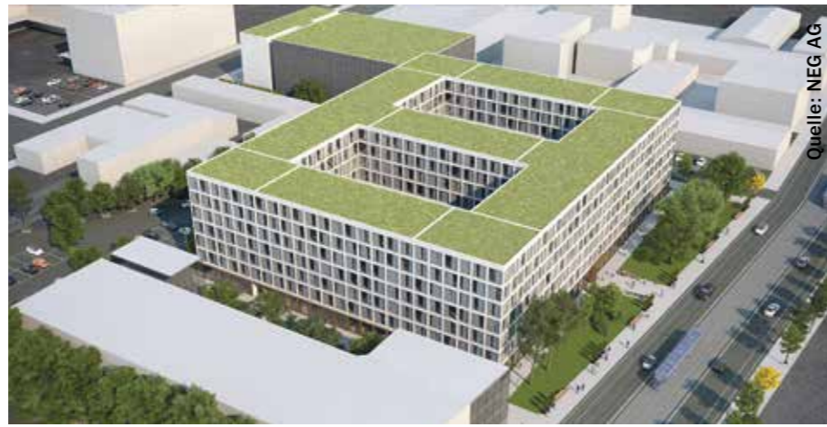
Die NEG AG plant auf der Berliner Straße einen Neubau, in dem vor allem Büros entstehen.
