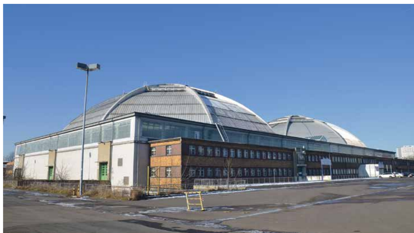
Zustand des heutigen Kohlrabizirkus
