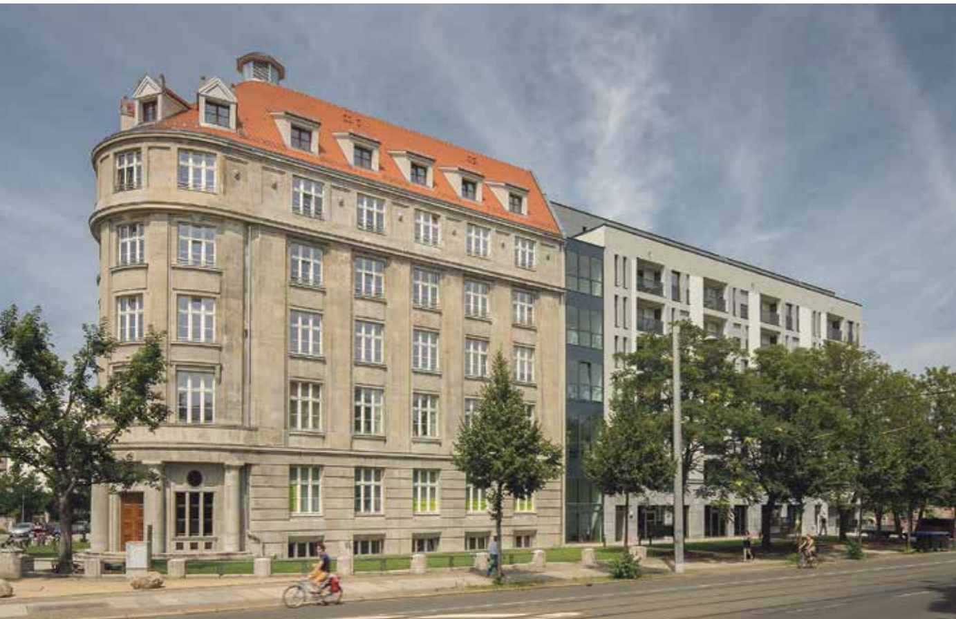
Im Oktober bezieht der erste gewerbliche Mieter den Neubau im Interdruck-Palais an der Dresdner Straße. Fotos: CG-Gruppe, Steffen Spitzner, Annette Koroll, KIST Büro- und Objekteinrichtung.
