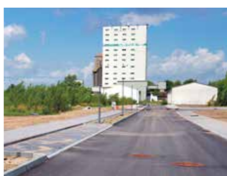
Erschließungsstraße und Speichergebäude im nördlichen Bereich Foto: Armin Kühne
