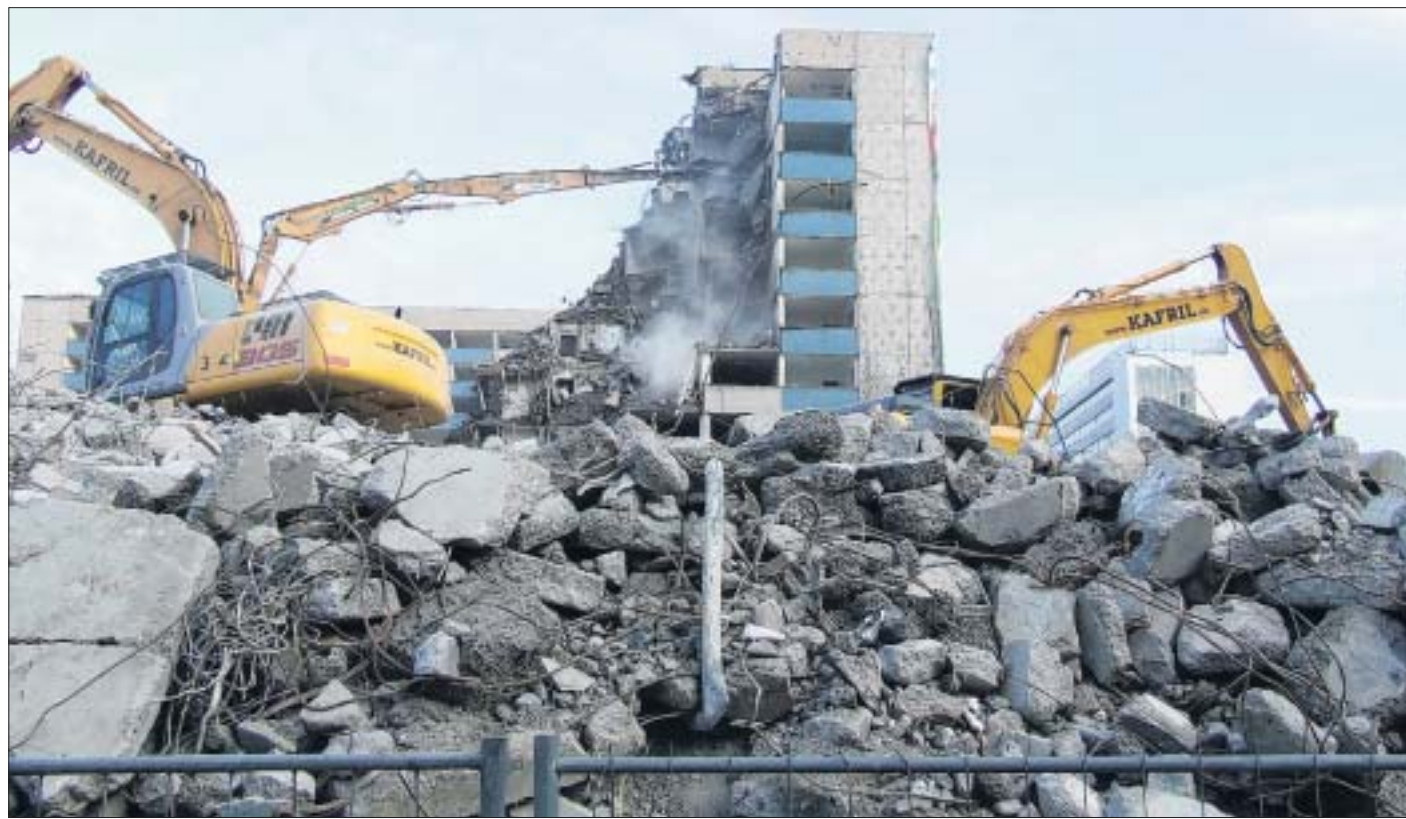
Stadtumbau Ost: Noch dominiert der Abriss von Wohnungen.
